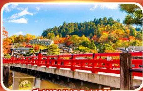
สะพานนากะบาชิ
